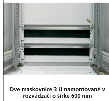
Zadný plechový kryt rozvádzača skrátený dvakrát o maskovnicu 3 U s protiprachovou záslepkou [E]
