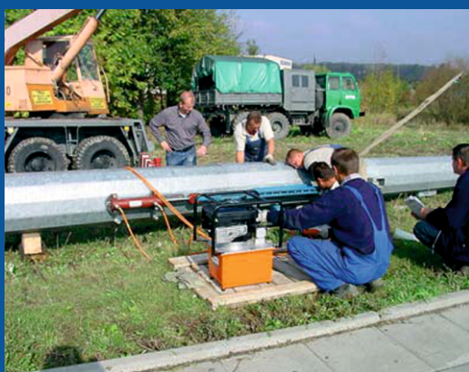
Spájanie sekcií stožiara Section assembling with use of jacking system Монтаж секций опоры при помощи домкрата
